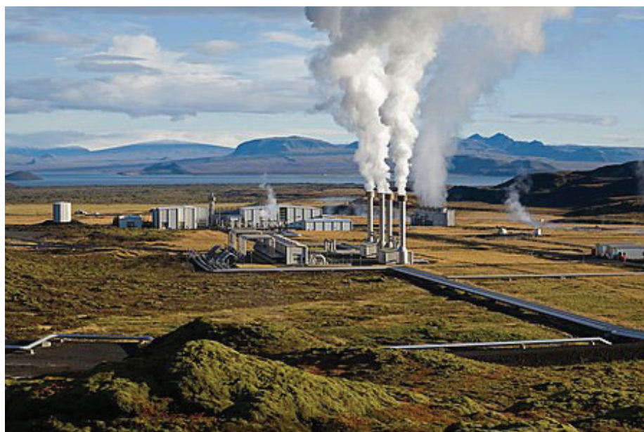
Рис. 1. ГеоТЭС Несьяведлир, Исландия. Электрическая мощность 120 МВт. Кроме того, станция вырабатывает 300 МВт тепловой энергии, которой отапливается столица Исландии – Рейкьявик («дымящаяся бухта»), насчитывающая 136 тысяч жителей. (Источник: https://upload.wikimedia.org/wikipedia/commons/thumb/9/9f/NesjavellirPowerPlant_edit2.jpg/450px-NesjavellirPowerPlant_edit2.jpg )
